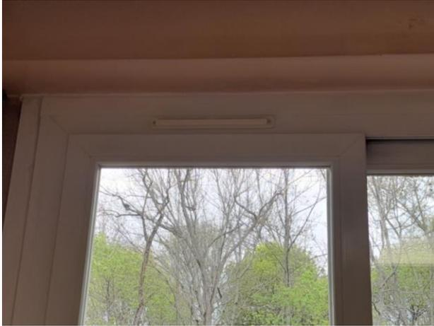
Figure 1 : Réglette d'entrée d'air sur fenêtre Source : Cerema
