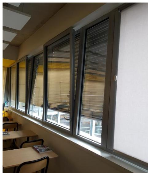
Figure 2 : Fenêtre en position oscillo-battante Source : Cerema
